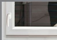
Poignée abaissée conforme à la norme PMR
